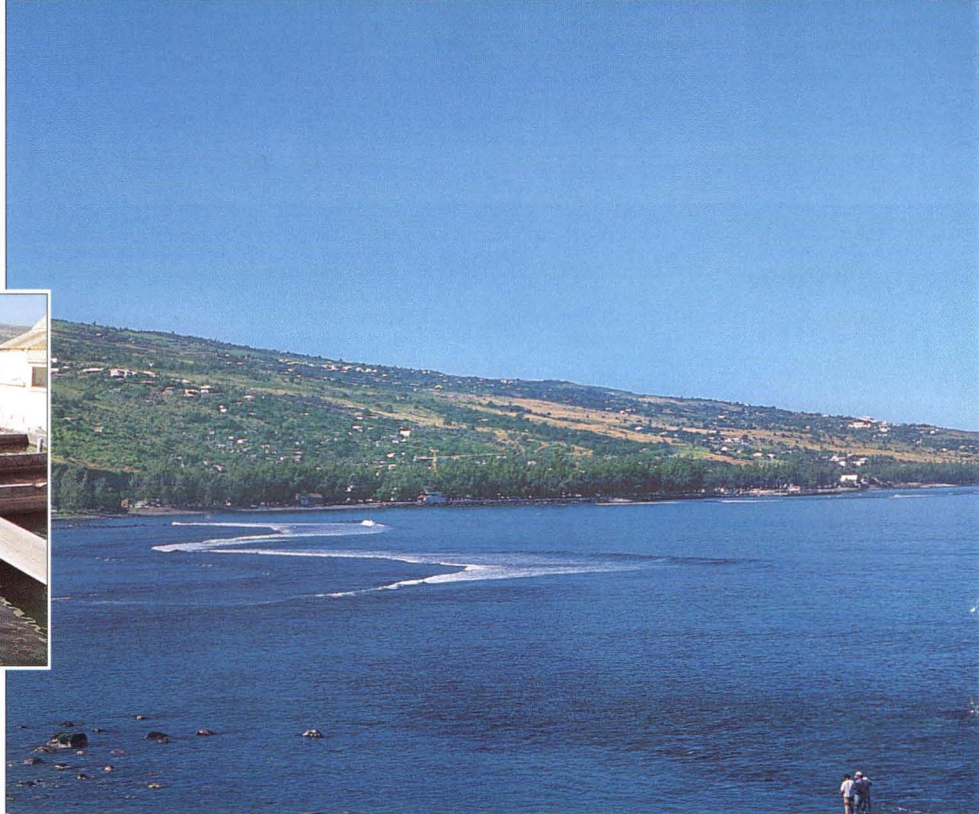
La ferme est implantée dans la baie de Saint-Leu. Elle comprend 1 500 m 3 de bassins dont on distingue, ici, une partie.
