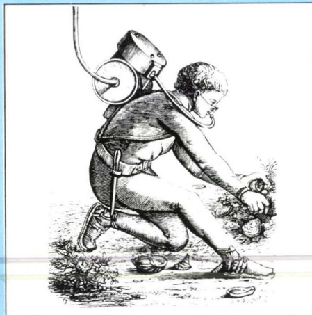
Plongeur au travail avec l'appareil Rouquayrol-Denayrouze qui est, on le remarque, d'une simplicité étonnante.
